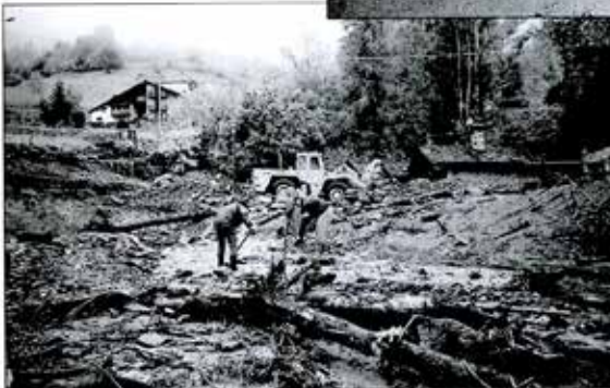
Tempestivi interventi da parte dei numerosi volontari. Prato nei pressi del forno (Ozein)
